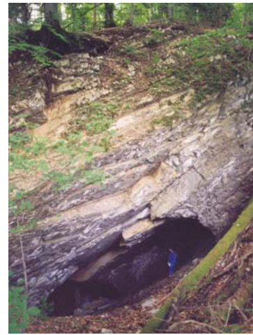
Figure 5 : Rupture d'une tête de veine pentée – effondrement en forme de « tiroir »
