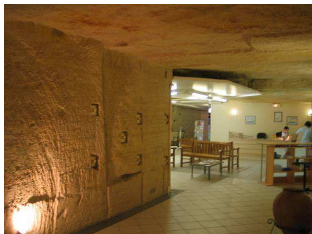
Photo 7 : Entrée du site souterrain avec plafond drainant
