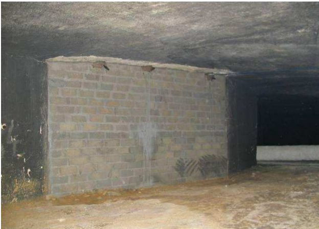
Photo 4 : Rétablissement de la portance par construction de piliers maçonnés
