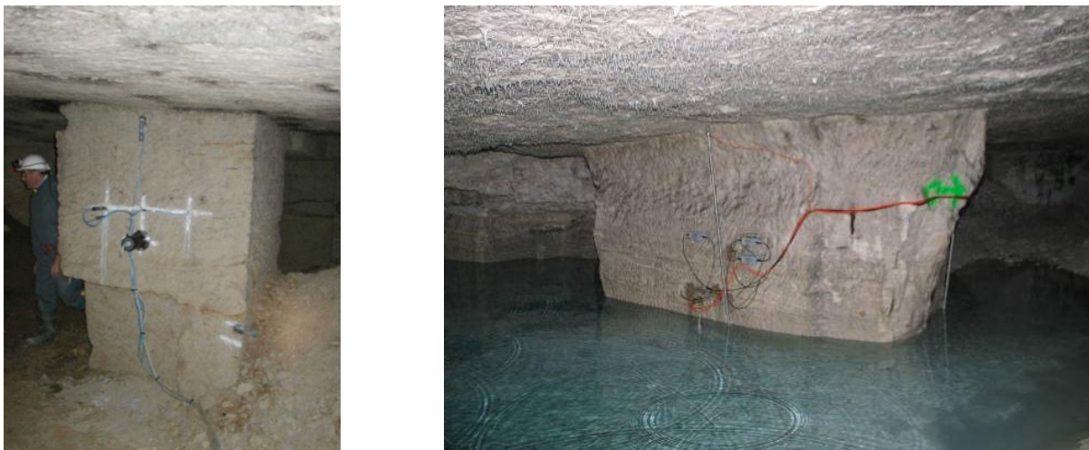
Figure 3 . Vue du pilier instrumenté dans la cavité de Saint-Martin-Le-Nœud (Oise)
