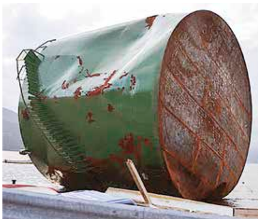
Figure 1 / Photographie post-accidentelle : renversement d'un réservoir par le tsunami (Japon, 2011).
