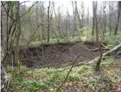
Figure 1. Effondrement localisé au droit d'une ancienne mine de fer de Lorraine (Ineris)
