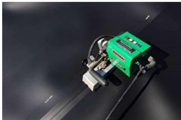
Figure 2 – Réalisation de soudures sur géomembranes bitumineuses à l'aide de matériel électrique
